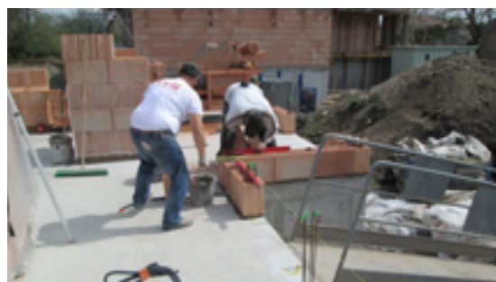
Préparation de la première rangée de blocs
