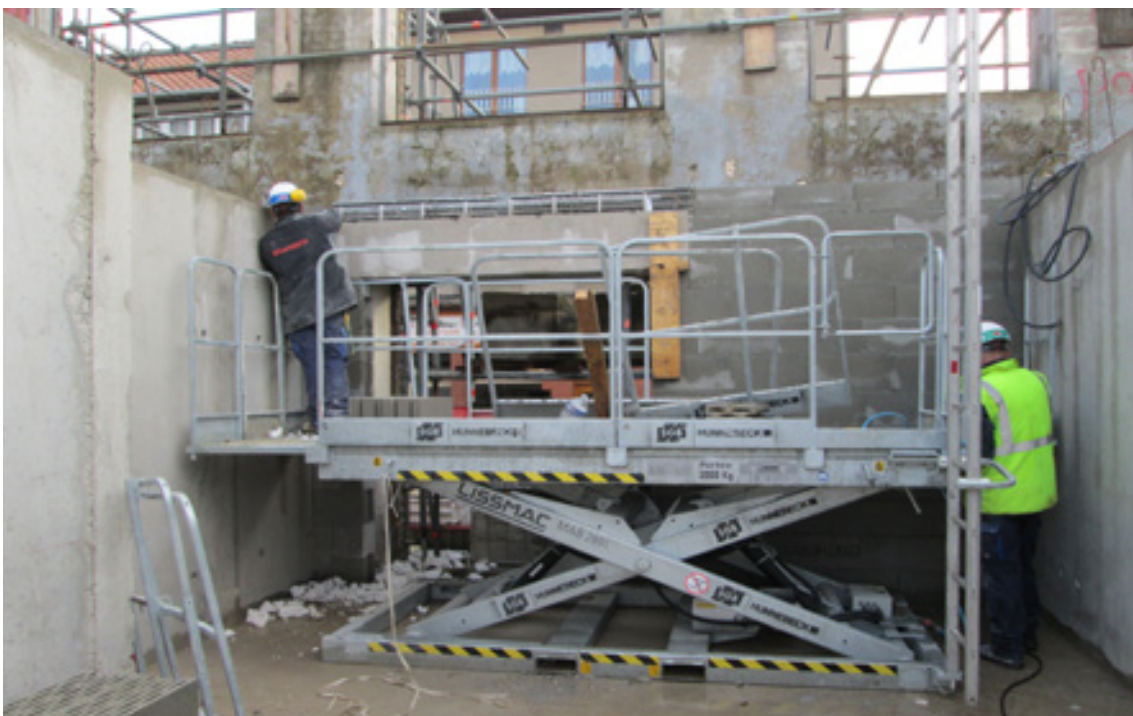
Déploiement de plateforme à maçonner
