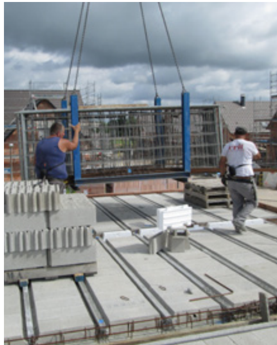
Déchargement de blocs
