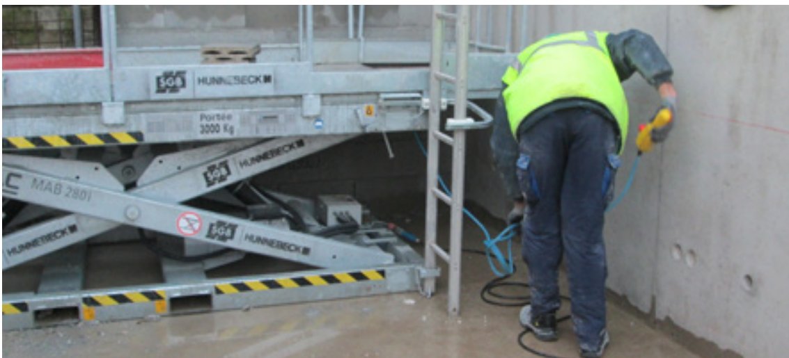
Mise à niveau de la plateforme à maçonner
